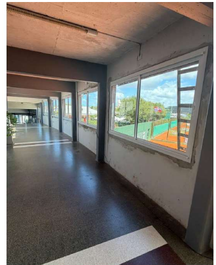
Nuevas aberturas pasillo canchas de tenis
