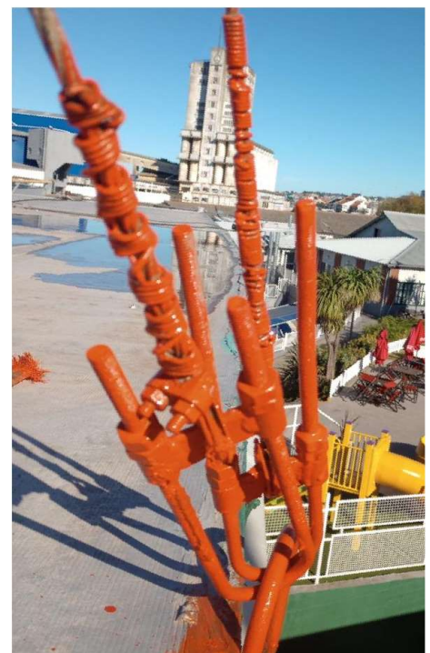
Reparación Torre de Comunicación
