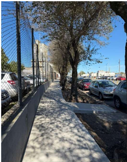
Obra vereda perimetral
