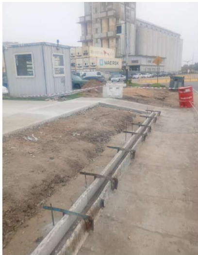
Obra vereda perimetral
